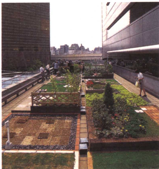
2002年5月开园的东京墨田区政府机关大楼（1990年竣工）裙楼的屋顶庭园。施工面积约200m 2 ，由34个施工单位做了分区绿化
