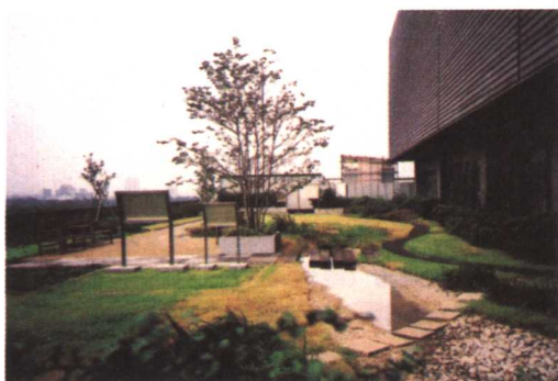
国土交通省（中央集结机关大楼3号楼，1975年竣工）的屋顶庭园。施工面积约500m 2 ，建于2001年9月。霞关一带（东京的政府机关集中地段。译注）现有的这类省厅机关大楼都在进行屋顶绿化
