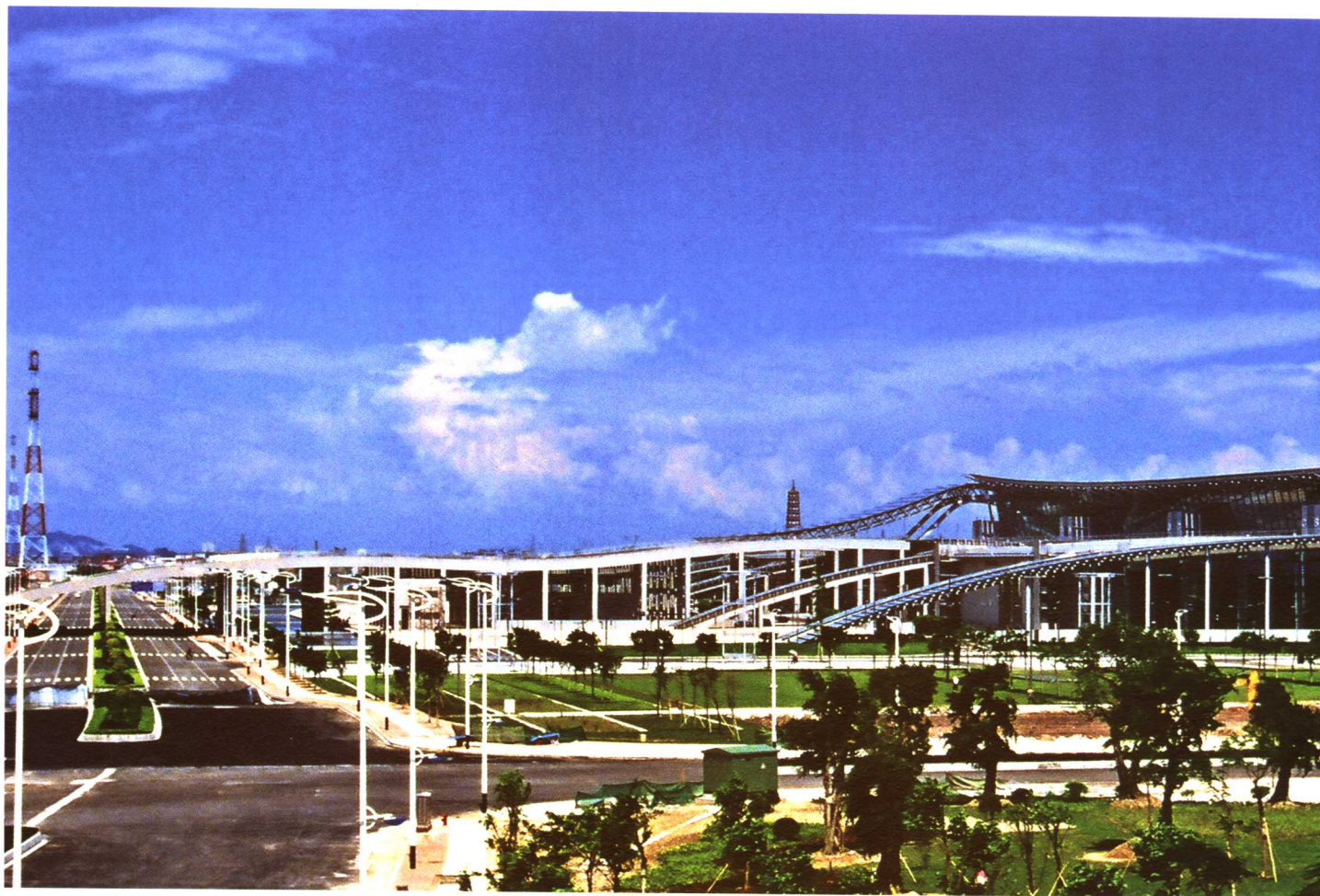
上：广州国际会展中心西立面外景
