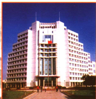
学院电教大楼
