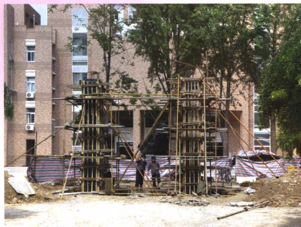
2、灌混凝土基础、柱、梁
