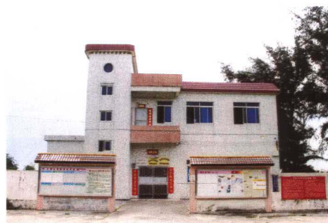
曹冲村委会办公楼
