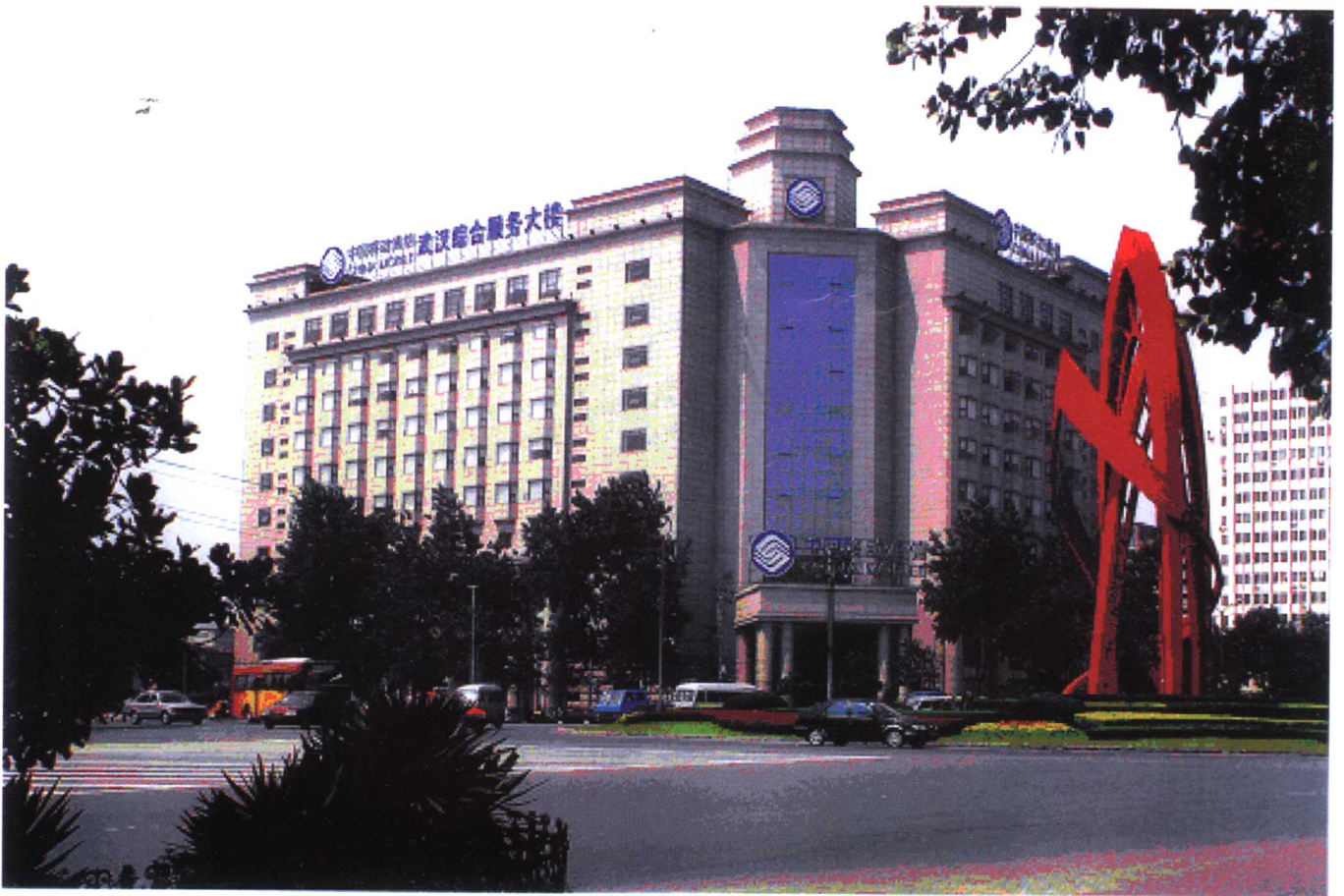
湖北省移动通信业务综合楼
