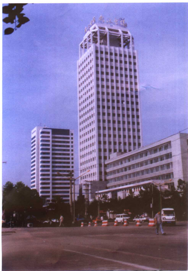
武汉市电信局市内电信综合楼
