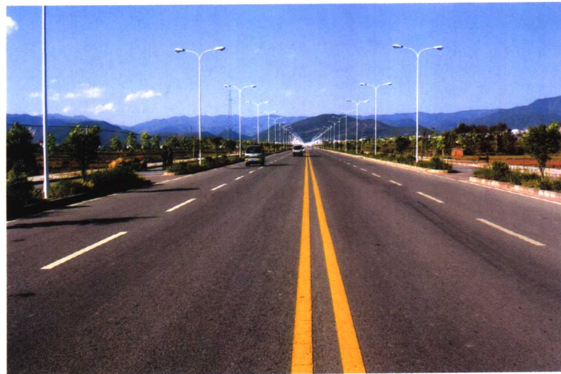
大理州新建的公路设施
