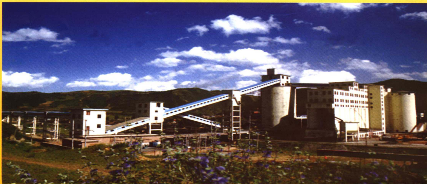
砚北煤矿工业广场
