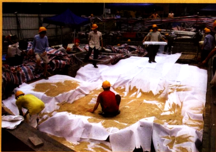
“中共三大”遗址保护工程 (遗址回填和展示部分综合设计、保护工程施工)
