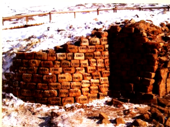
世界文化遗产高句丽丸都山城西南门石构件保护 (石构件粘接、加固及保护)
