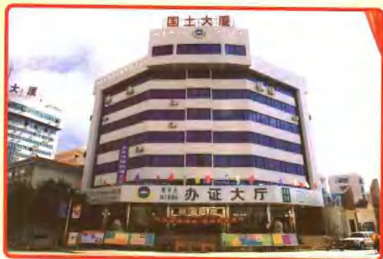
◀县国土资源局办公大楼。
