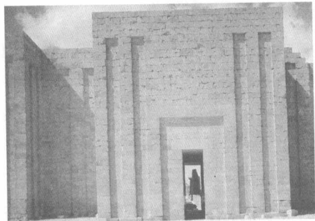
2.2-3 萨卡拉阶梯式金字塔的周壁，公元前 2620 年—公元前 2600 年，版状凹凸的外壁高 10 米，共有 14 个门，其中 13 个是假门，只有 1 个是真门。
