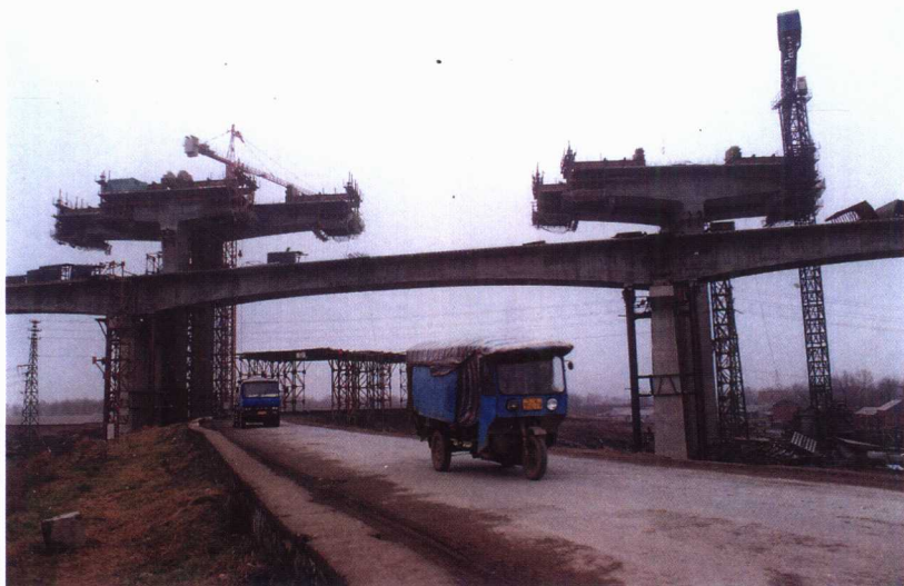
无为岸公路引桥悬浇施工
