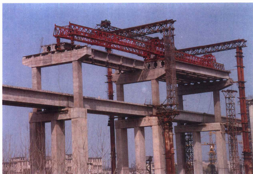
引桥简支梁架设
