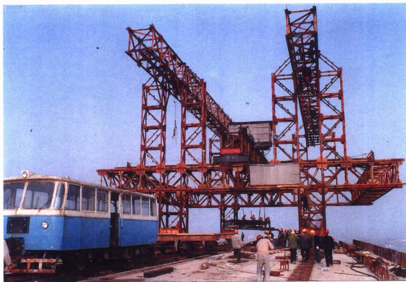
连续梁桥面板架设
