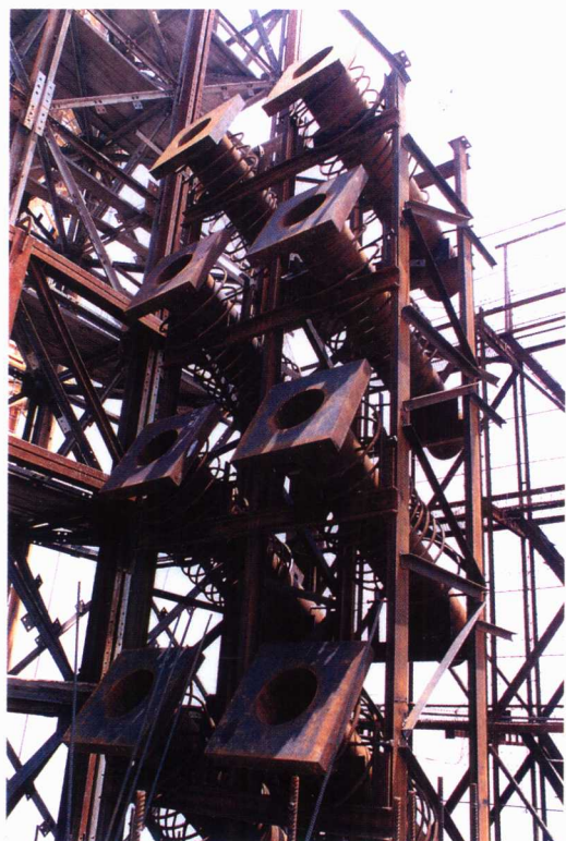
主塔索导管安装定位
