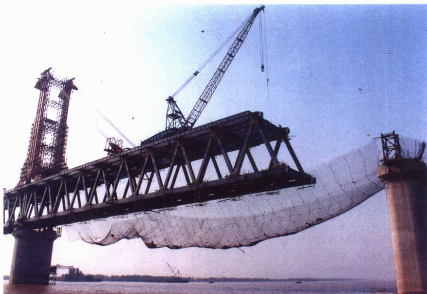
连续钢桁梁架设
