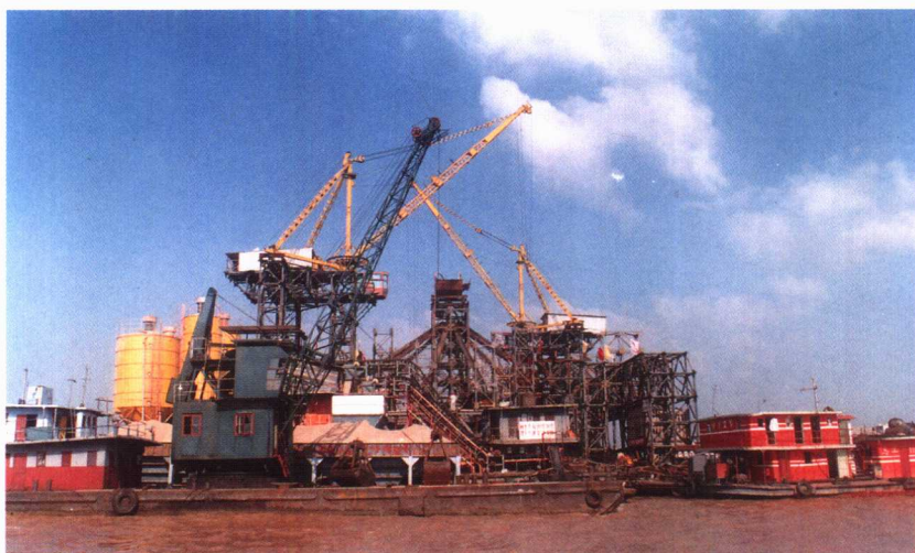
水上混凝土工厂
