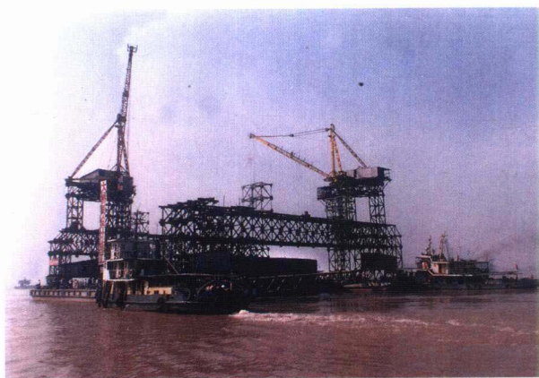
双壁钢围堰浮运
