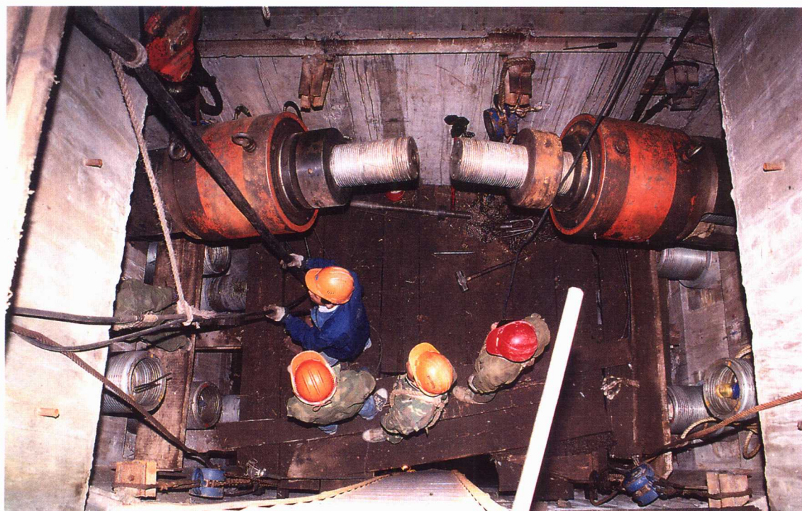
塔端张拉斜拉索
