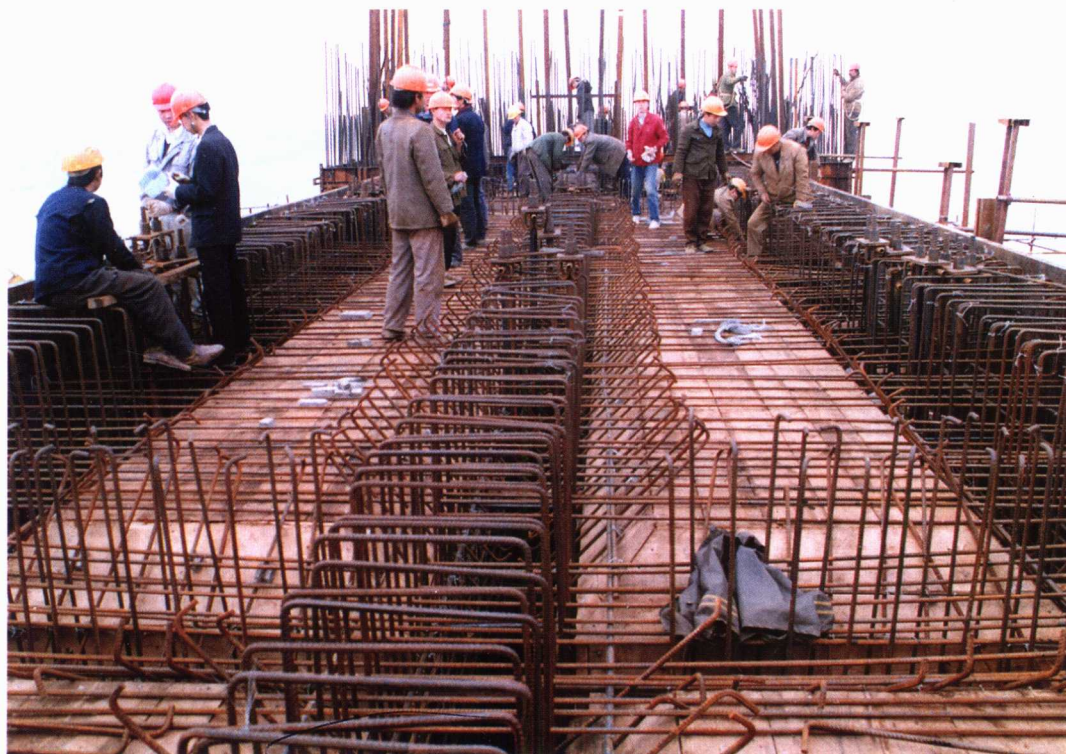
主塔横梁施工
