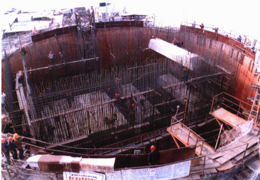
主塔下塔柱施工
