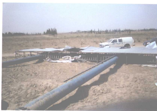
被大风吹倒的大型广告牌
