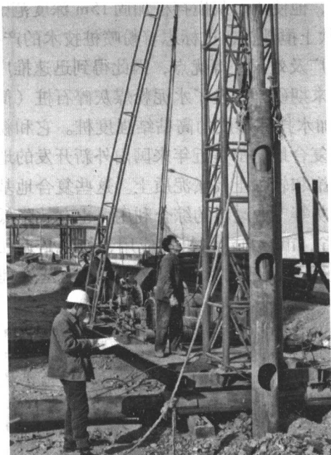
图 1-5 锤击碎石桩复合地基施工
