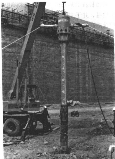
图 1-6 干振碎石桩复合地基施工
