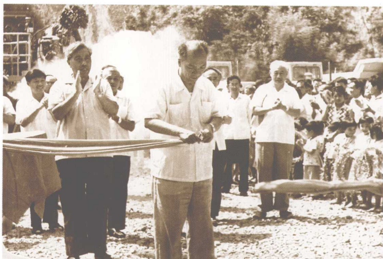
1982年6月28日，广东省副省长李建安为大瑶山隧道四臂台车进洞作业剪彩。
