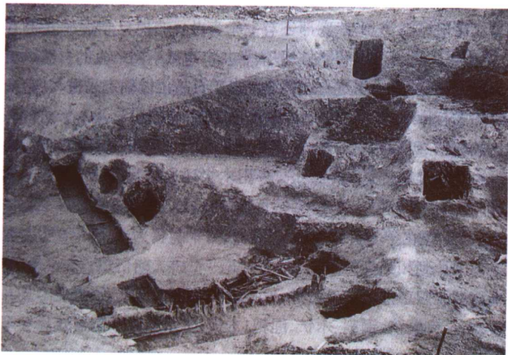
商周时期瑞昌铜岭铜矿以井巷采矿，并使用井巷木支护、轮轴和木溜槽等先进的采矿、吊运、选矿技术。此为考古发掘的井巷遗址。
