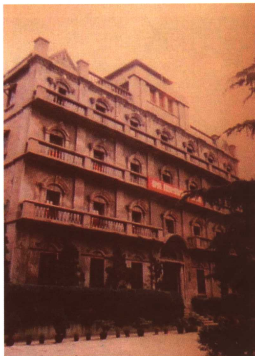
1919年兴建的南昌大旅社(现八一南昌起义纪念馆)采用钢筋混凝土材料和“回”字形结构
