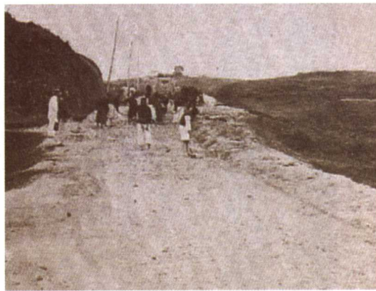
民国时期江西采用滚压、耙沙等技术修筑了大量的低等级沙石公路。此照片为民工修筑赣湘线铺沙石路面时的情景。
