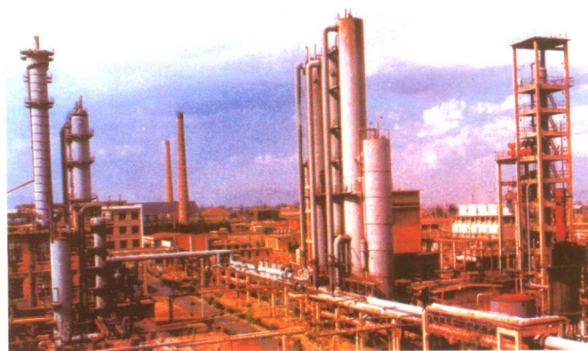
20世纪80年代末太原煤炭气化公司煤气加工系统
