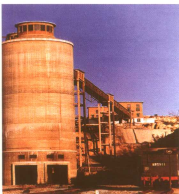
东山煤矿筒仓
