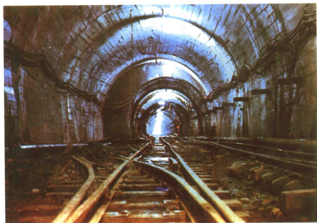
20世纪80年代西山矿务局古交矿区大型国有煤矿主巷道
