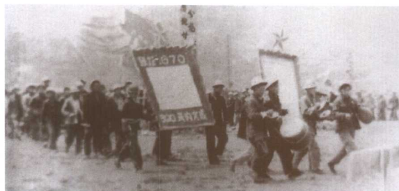
1958年4月太原氮肥厂破土动工
