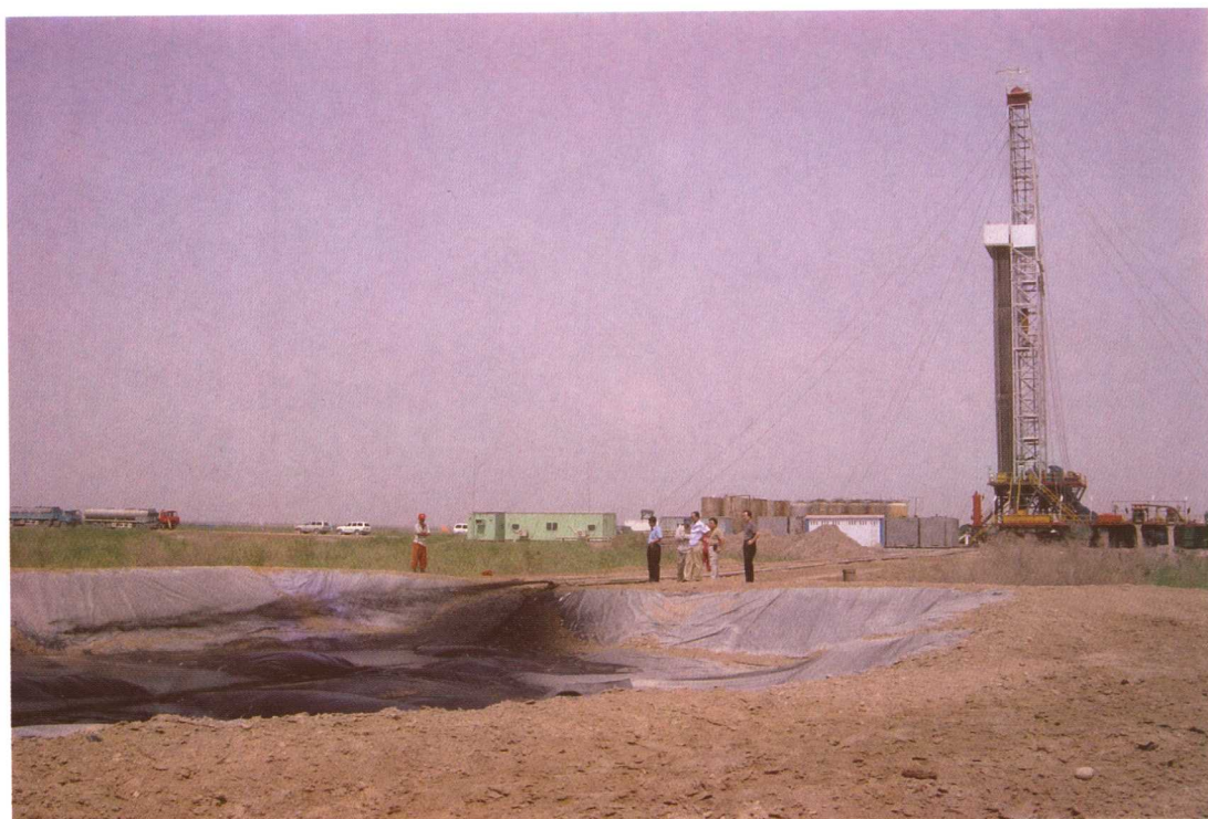
彩图 16 钻井放喷池铺设的防渗膜
