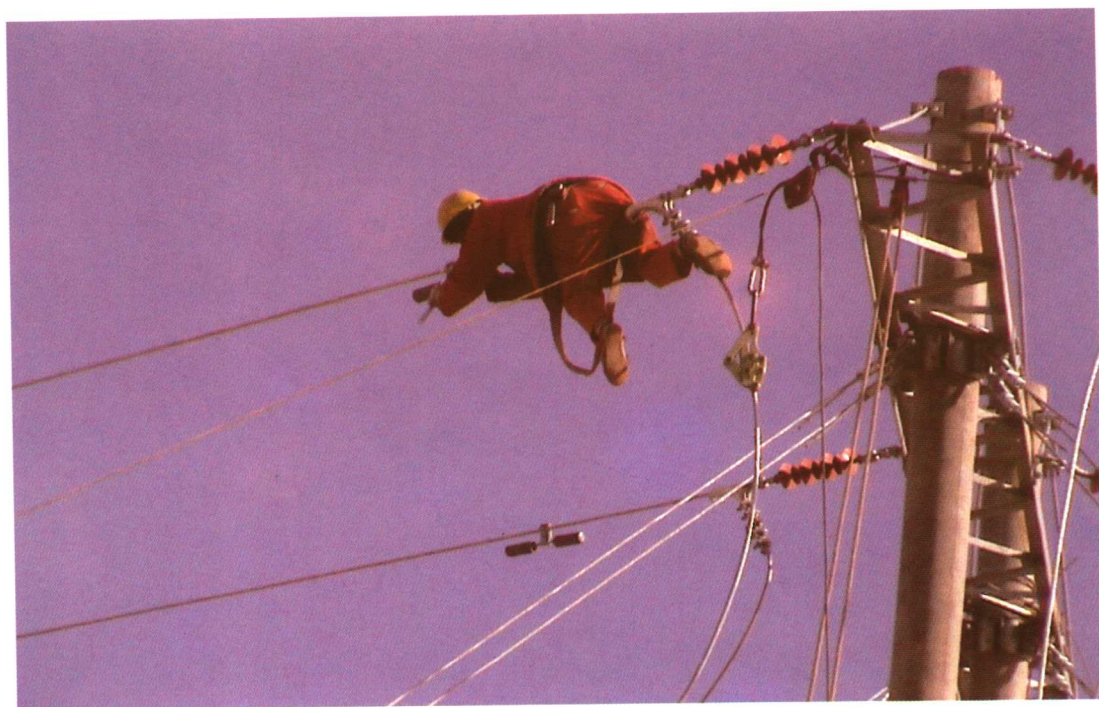
彩图 15 轮西 35kV 电力线路架设
