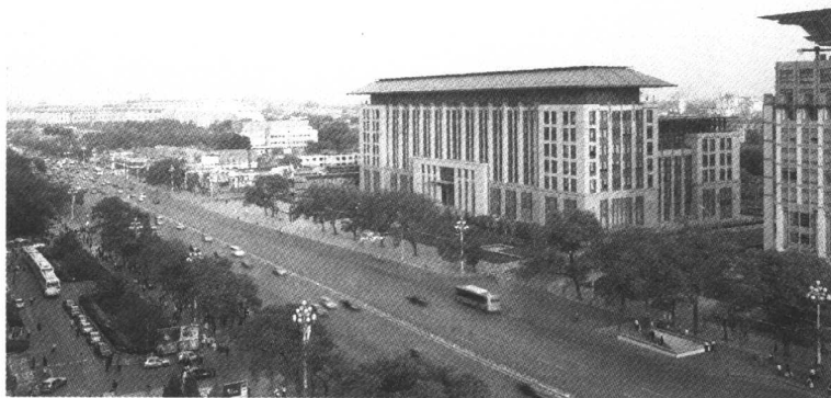
图 1-1 中组部新办公楼北立面
