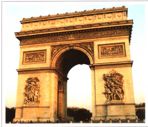
连续图案在建筑的装饰中也十分常见。在屋檐、墙角等处, 二方连续的立体雕刻图案常常随着建筑的外围延展, 环绕, 既丰富了建筑的表面视觉效果, 又保持了整体形式的统一。
