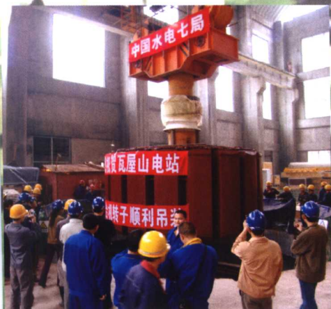
首台机组270吨转子吊装成功
