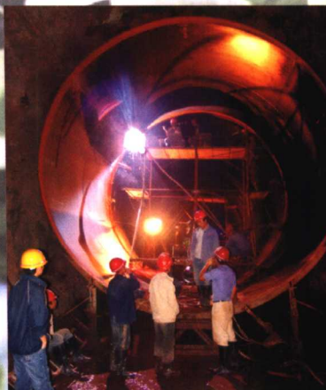
内径6.2米的压力管道施工
