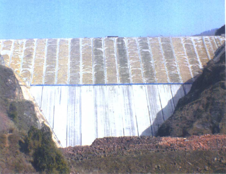
填筑317万方，垂直高度138米的瓦电大坝。
