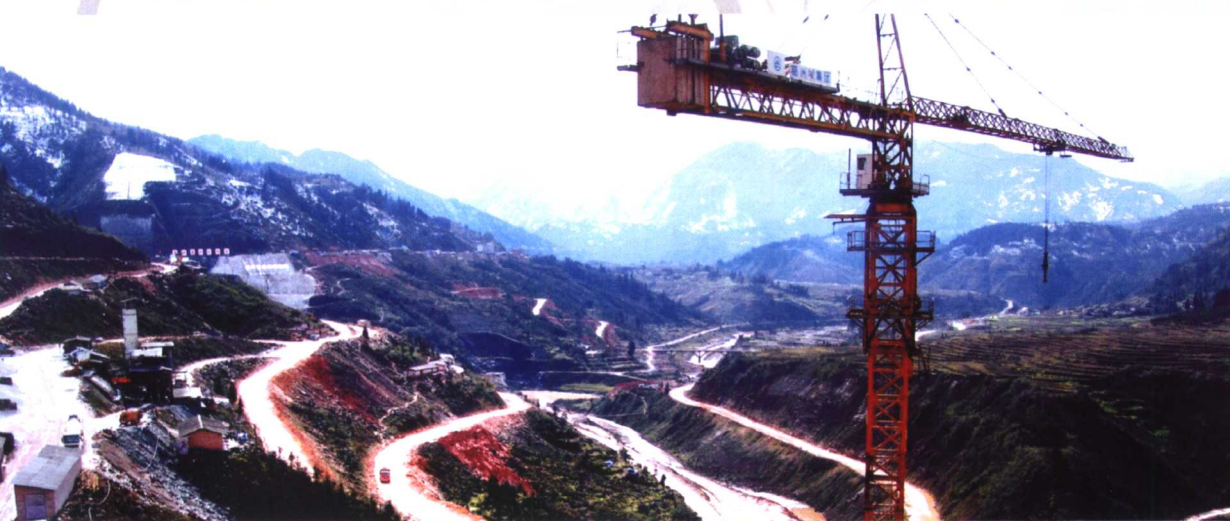
瓦电工程大场景
