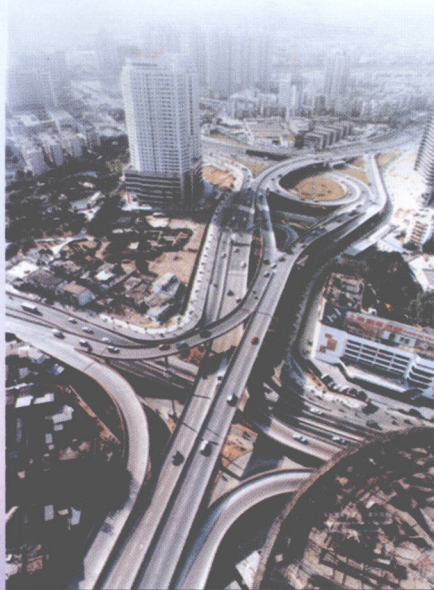
深圳雅园立交桥
