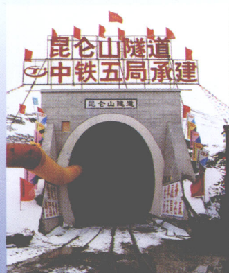
世界海拔最高的昆仑山隧道
