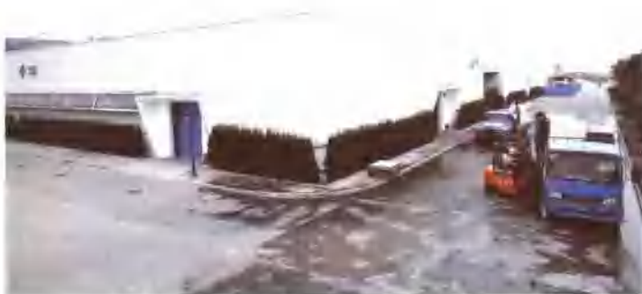
中盐上海市食盐配送中心(闵行)仓库外作业现场
