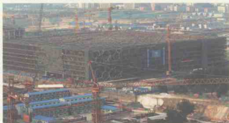
图3 2008年北京奥运会游泳馆施工实景
