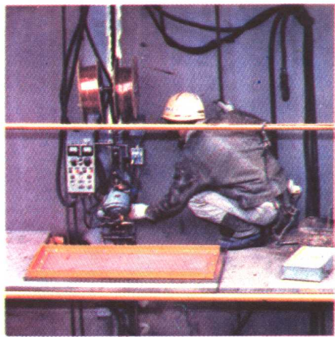
惰性氣體自動立焊操作情形
