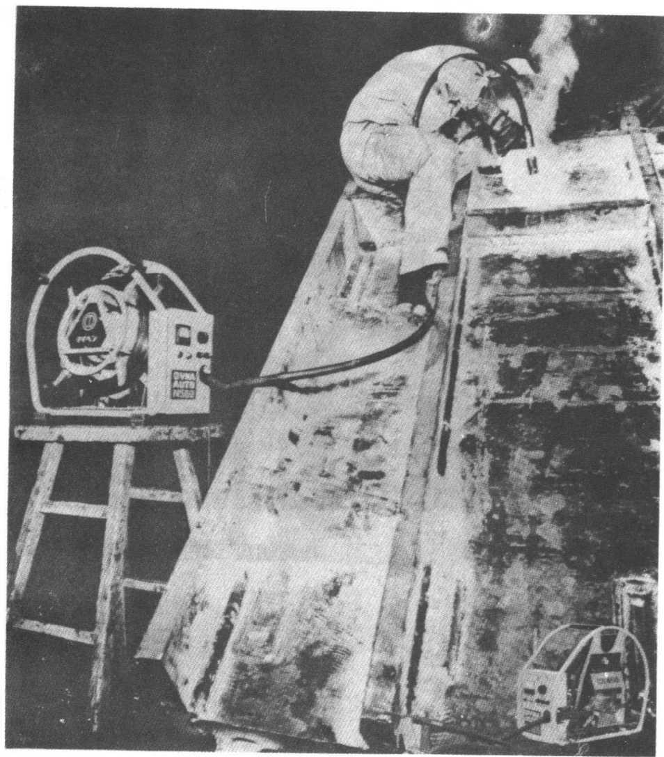
無氣體半自動電焊機操作情形
