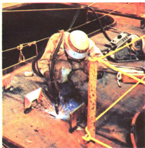
CO 2 半自動焊接情形
