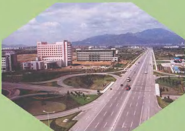
新区南天门大街互通式立交桥
