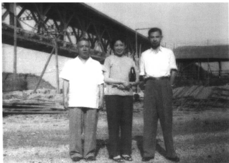
曹聚仁在武汉长江大桥工地，摄于1957年夏
