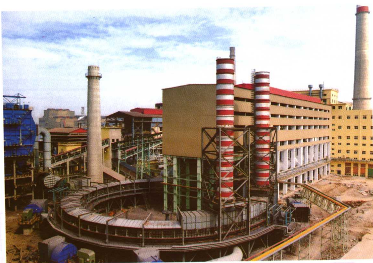
6月28日开工建设的400m 2 烧结机工程
