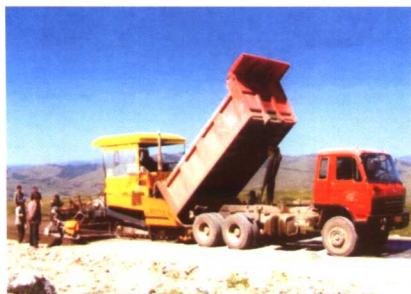
新疆筑路机械厂公路工程施工现场
