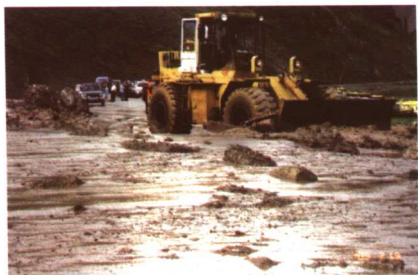
伊犁养路工人在果子沟清除泥石流
