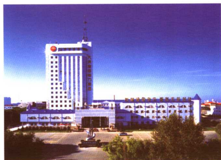
大庆石油管理局电力集团是全国石油系统最大的电力企业，总发电量居全国企业自备电厂首位
