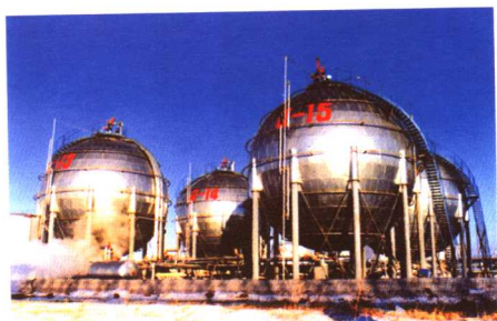
大庆石油管理局的大型球罐施 工、大型立式储罐施工技术达 到国内先进水平，大型储罐整 体搬迁技术为国内首创
