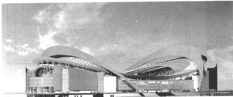
图1 南京奥体中心主体育场
