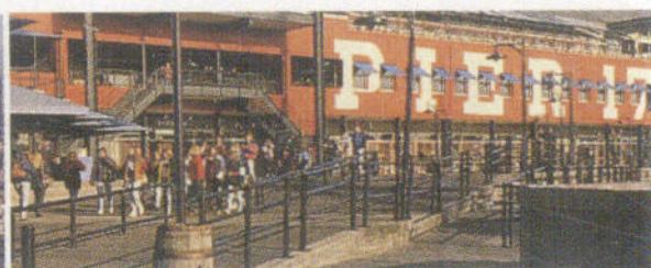
南街海港十七号栈桥
