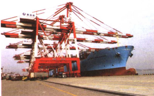
高大挺拔的大型桥吊群
