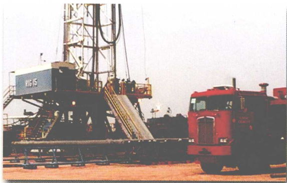
● 钻井技术服务公司苏丹固井项目组大功率固井车在苏丹施工。
