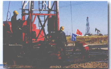
●2002~2003年,共完成大修井7602口,小修井27630口。
