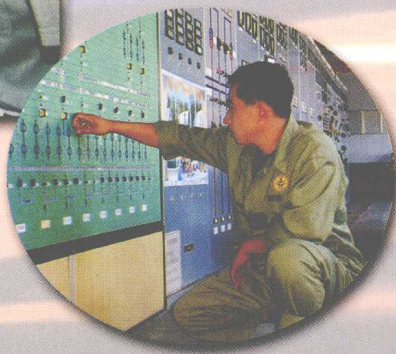
● 供电公司加强供电成本费用项目控制。
