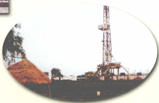
● 在苏丹施工的 GW56 钻井队施工现场。
