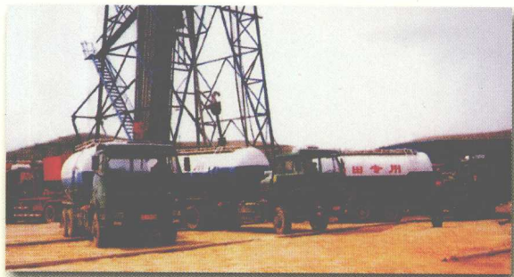
● 在陕西长庆固井施工现场。
