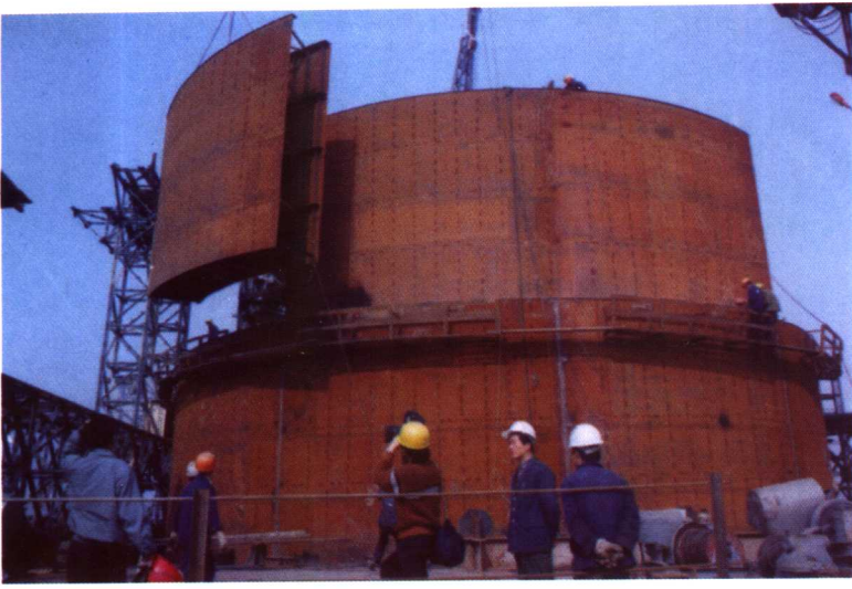
● 双壁钢围堰在水上接高
