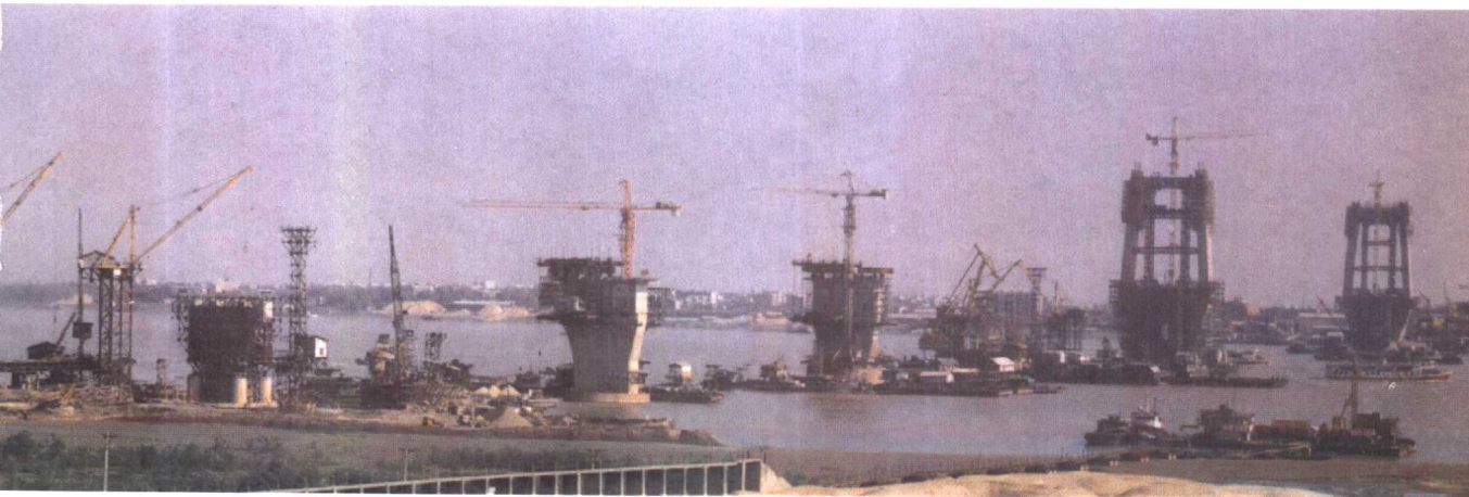
● 水上桥墩施工全景
