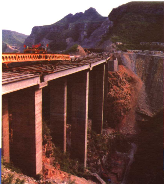
架桥机紧张施工
