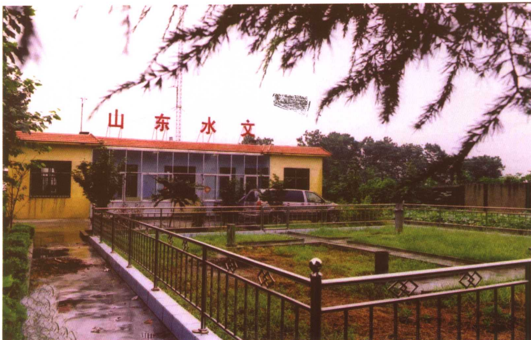
二级坝闸水文站站房及观测场
