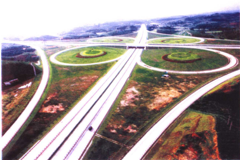
钦州至防城港高速公路
