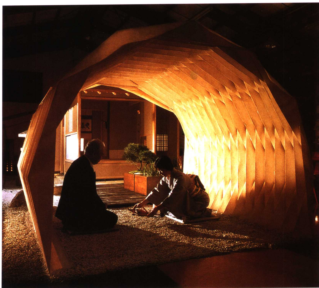
3 使用大型折纸的茶室, 仅用6米四方形日本纸完成的。若折叠起来仅厚6厘米, 便于搬动。使用透光的日本纸, 形成一座别有风韵的休憩小屋 (刊登于朝日新闻2000年11月25日晚报)
