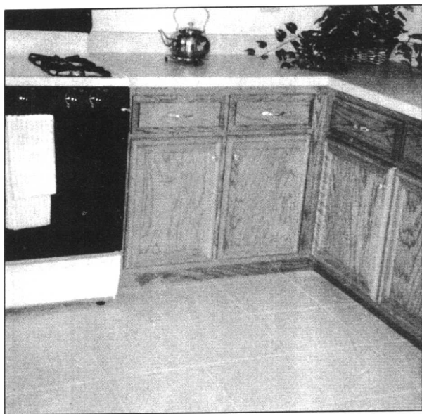
弹性乙烯地板砖是最便宜的铺地材料，它美观、经久耐用，通常被用在厨房和卫生间
