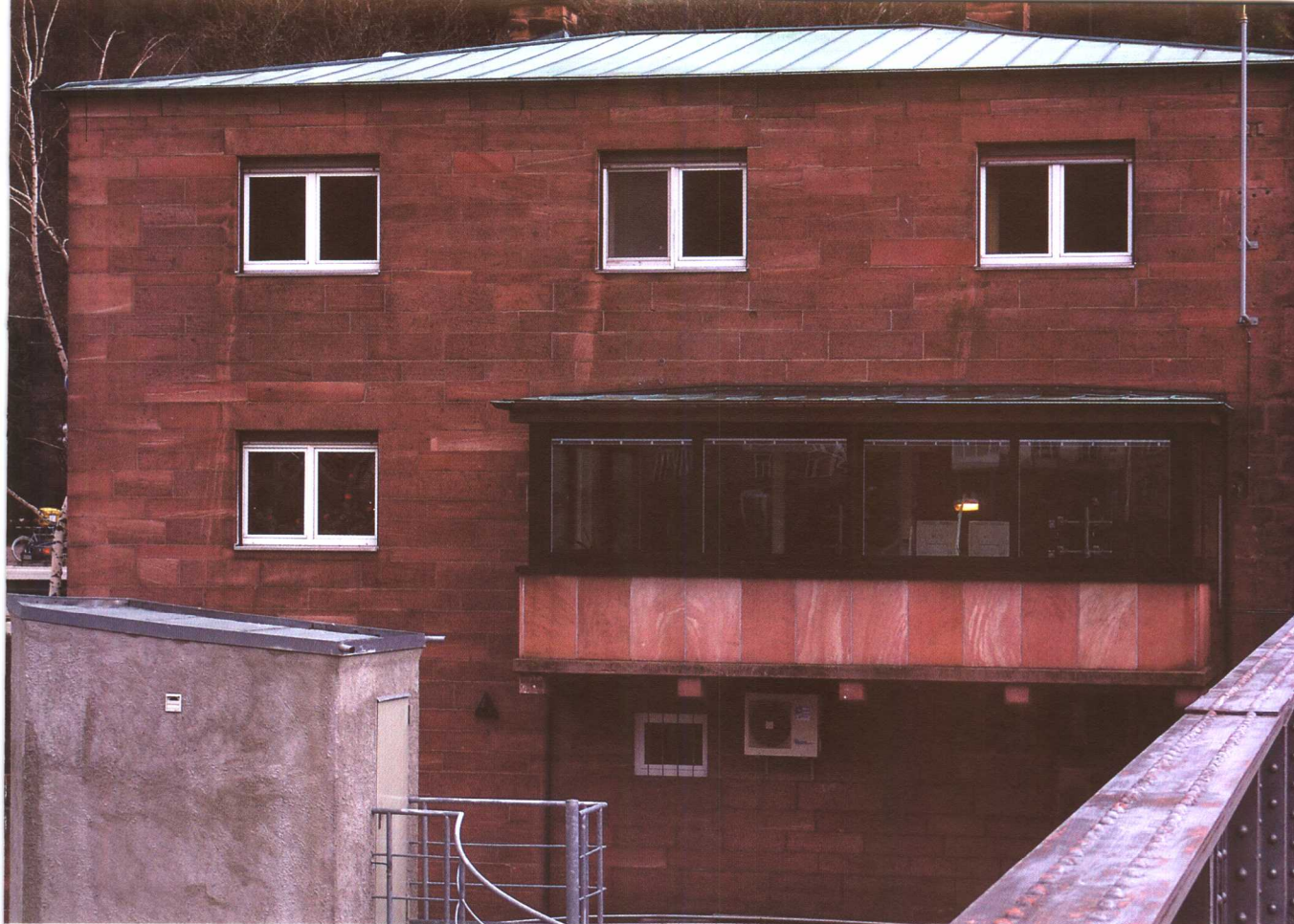
内卡河上的水闸机房
