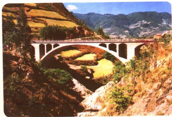
1998年建成的南——景公路双波郎桥（时为云南省县乡公路最高的桥梁）
