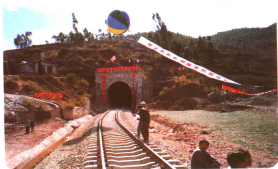
广大铁路南华段最长的隧道——龙摩山隧道
