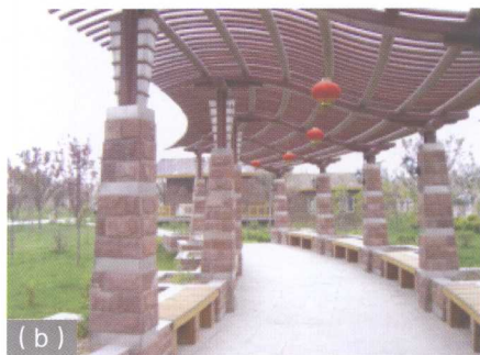
彩图 3-14 单排曲线式钢木石结构双面空廊 (西安)
