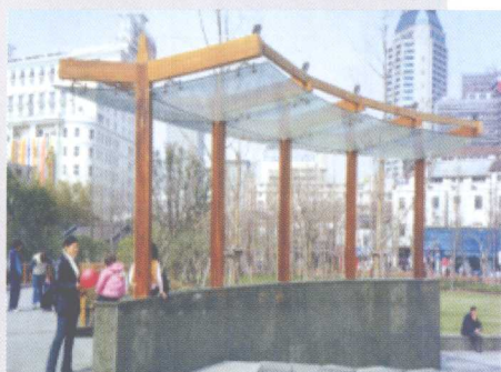
彩图 3-16 单排柱玻璃石木结构景廊 (上海)
