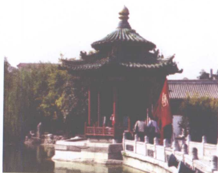
彩图 2-24 六角重檐 (上圆下方) 笠顶亭 (陕西)
