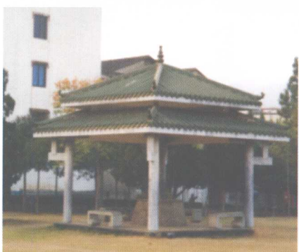
彩图 2-12 四角重檐四坡顶亭 (福州)
