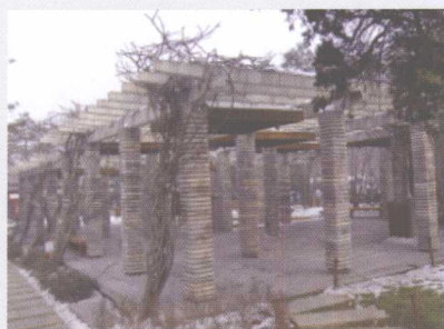
彩图 3-20 木构吊顶花架群 (西安)
