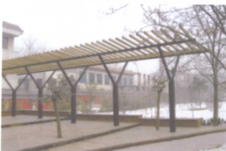
彩图 3-4 单排柱“Y”字形梁架式景廊 (西安)
