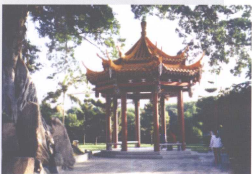
彩图 2-27 八角重檐攒尖顶亭 (福建风格)
