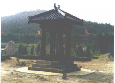
彩图 2-32 砖砌三步四方台基 (陕西)
