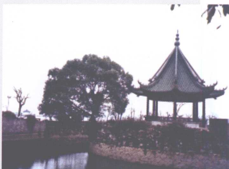
彩图 2-33 八角攒尖顶亭 (无锡风格)
