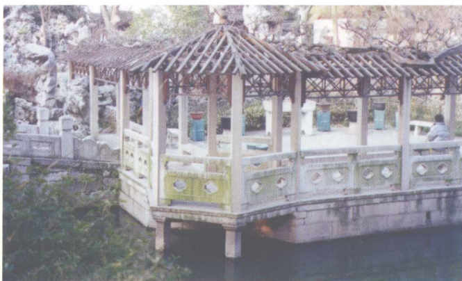
彩图 3-15 双排“L”形石木结构两坡顶花架 (苏州狮子林)
