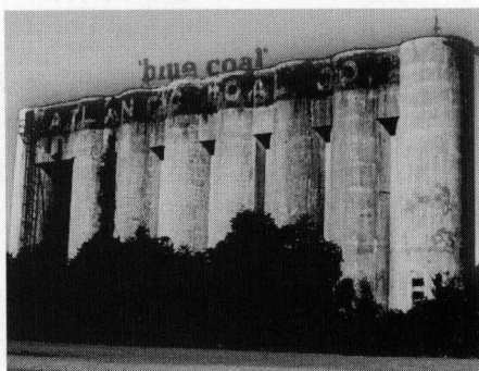
图 1-6 “蓝煤”储煤筒仓
