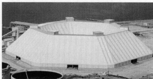
图 1-19 日本某电厂环形储煤结构
