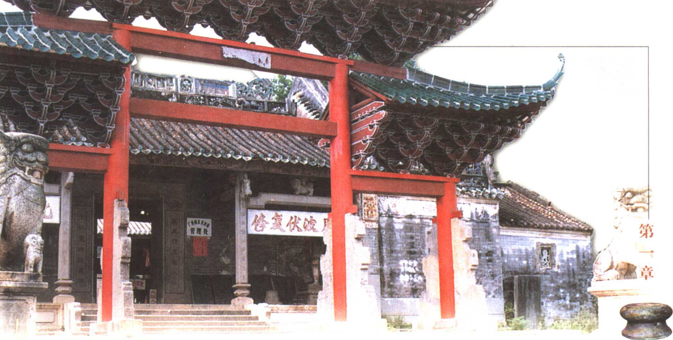
广西横县的伏波庙位于郁江乌蛮滩北岸，据传马援南征路过此地
