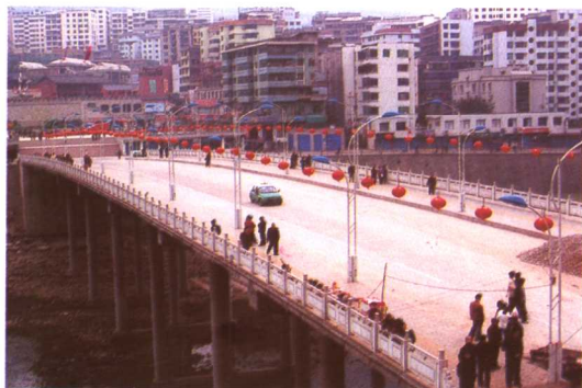
财政投资修建，2004年竣工的通江县红军大桥。
