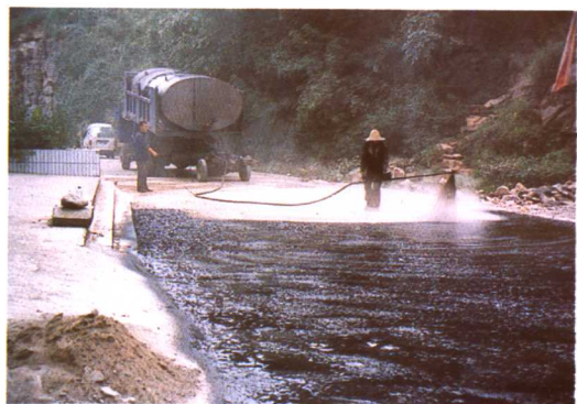
2005年7月，正在改建的杨（柏）火（炬）通乡油路撒油现场。
