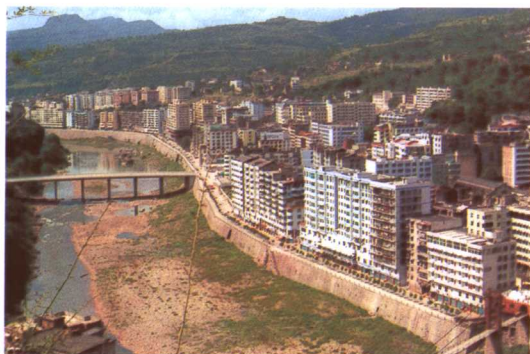
财政投资修建的通江滨河路。
