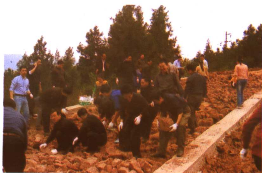
县财政局职工帮助因滑坡断路的毛浴乡沿江村村民修路的现场。
