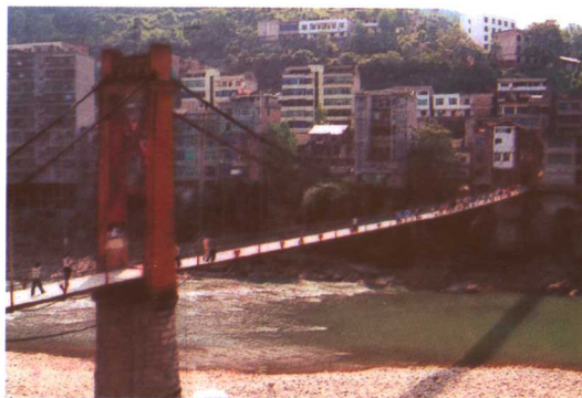
1989年5月31日，财政拨款29万元历时半年修建竣工的通江南门索桥。
