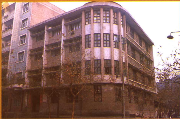
20世纪90年代经维修改建后的 财政局办公楼。
