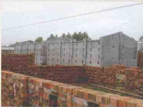
大邑县正在修建的标准化菇房
