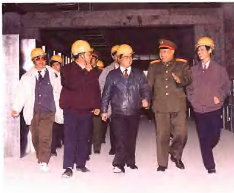
1993年3月，中共上海市委副书记、市长黄菊（左三），中共上海市委常委、上海警备区司令员徐文义（右二）视察正在施工中的人民广场工程
