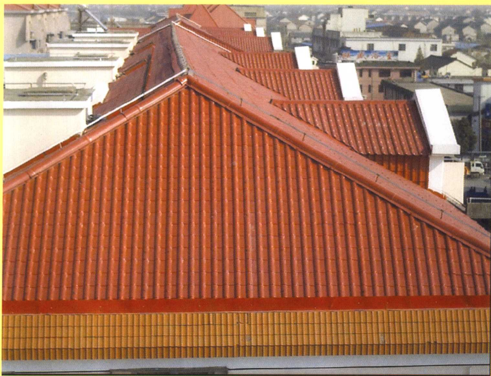
彩图 2 整治后的彩钢板屋面
