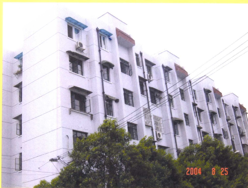
彩图 8 整治后的建筑外立面
