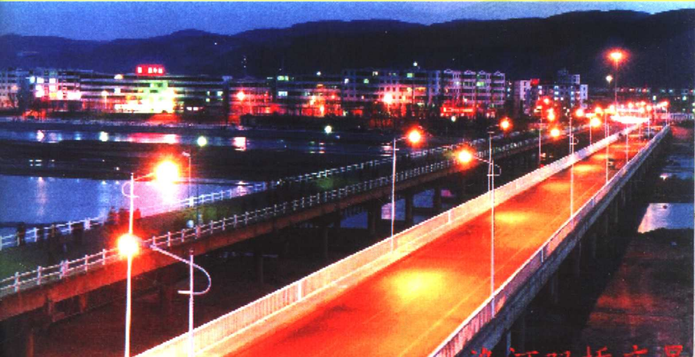
宜阳洛河大桥双桥夜景
